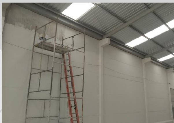
PINTURA INDUSTRIAL - LAGOS - ARCOS/MG
