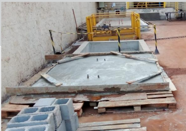
CONSTRUÇÃO DIQUE DE CONTENÇÃO VITVIA S.A - SP
