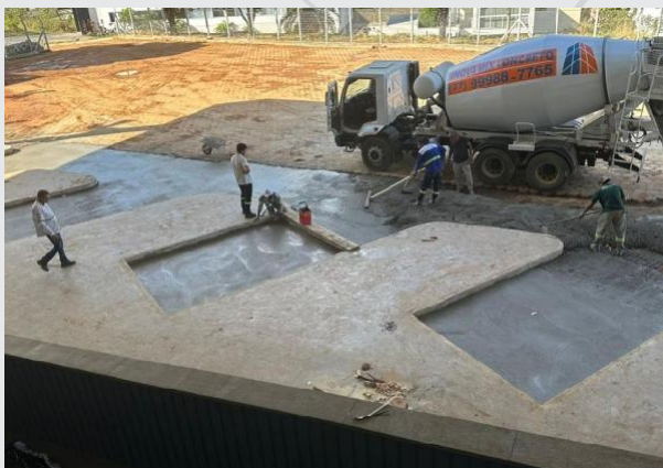
REFORMA PISO TERMINAL RODoviÁRIO
