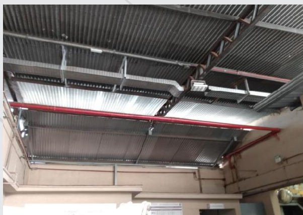
MANUTENÇÃO ELÉTRICA VITVIA S.A SP
